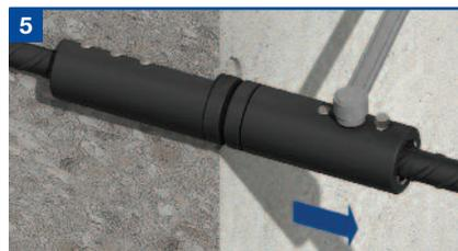
5 Inserte la barra de continuación en el componente macho y apriete los pernos a mano. Compruebe la alineación y haga los ajustes necesarios. Empezando desde el centro del acoplador y avanzando hacia el extremo, apriete parcialmente los pernos rompibles utilizando una llave de vaso o una llave eléctrica, según sea necesario. No utilice herramientas de impacto. Repita otra vez, esta vez apriete a fondo los pernos rompibles hasta que las cabezas de éstos se corten. Apriete a fondo la contratuerca.
