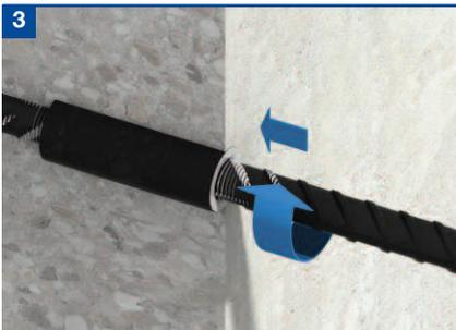
Siga atornillando la barra en el acoplador hasta que quede apretada.
