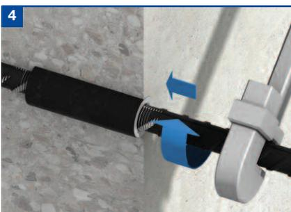
Para asegurar la instalación, apriete la junta con el par correcto utilizando una llave calibrada en la barra de continuación. Los pares de apriete correctos se muestran en la tabla de la página 5.
