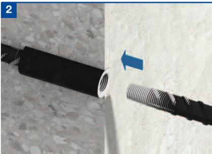
Con el hormigón fraguado y listo para colocar las extensiones, retire la tapa de plástico del extremo (y la placa con clavos, en su caso) del acoplador. Coloque la barra de continuación en el manguito y gire la barra para insertarla en el acoplador.
