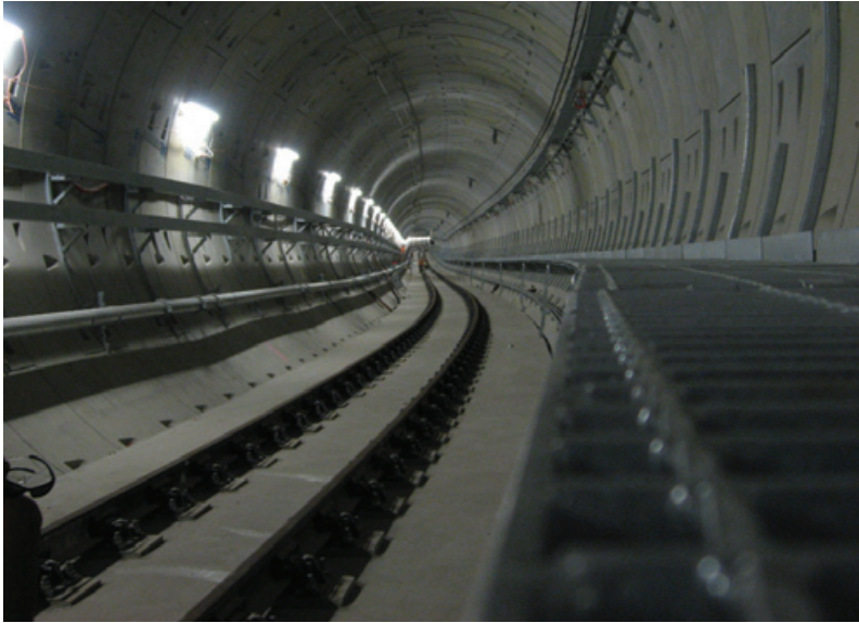
Passerelles de Maintenance. Projet: Tunnel Ferroviaire pour le Métro de la Ville de Perth, Australie (Entrepreneur: Leighton Kumagai JV)
