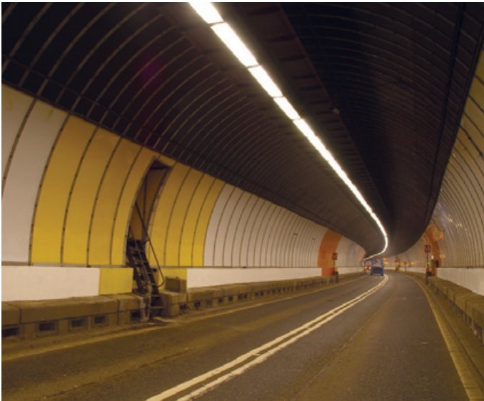
Revêtements de Tunnel. Projet: Tunnel du fleuve Clyde, Royaume-Uni (Entrepreneur: Byzak, Ingénierie: Faber Maunsell)
