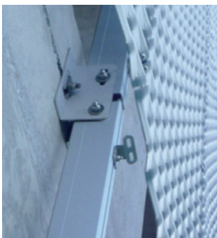
Fixations et Supports pour Revêtements Architecturaux (Façade: James and Taylor)
