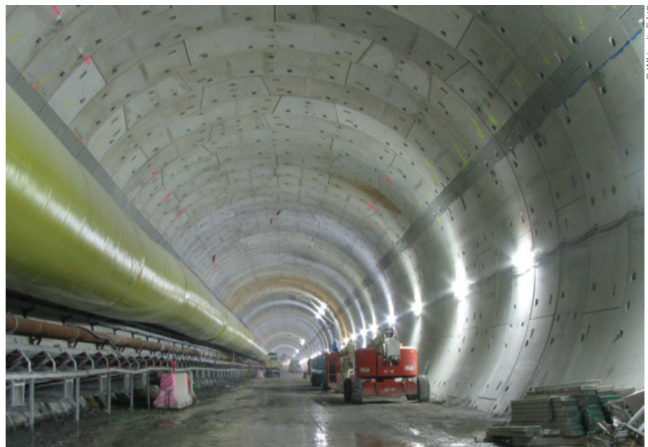
Projet: Bretelle de contournement nord-sud de Brisbane, Australie (Entrepreneur: LBB JV, Ingénierie: Bilfinger Berger)
