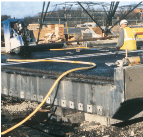
Plaques de Garde pour Tabliers Routiers. Projet: Tunnel de Dartford East, Royaume-Uni (Entrepreneur: Kvaerner/Skanska)
