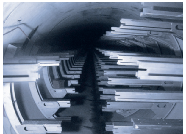
Projet: Tunnel pour Câbles de Carlton, Australie (Client: Energy Australia, Entrepreneur: The Abergeldie Group, Ingénierie supports de câbles: Ancon)
