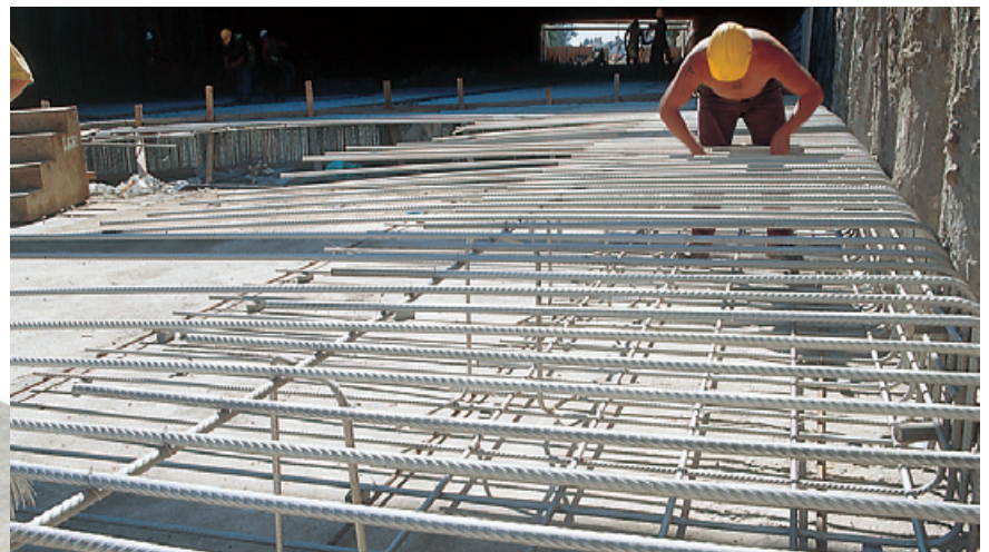
Armatures Façonnées. Projet: Contournement de Cradlewell, Royaume-Uni (Entrepreneur : Alfred McAlpine/Carillion)
