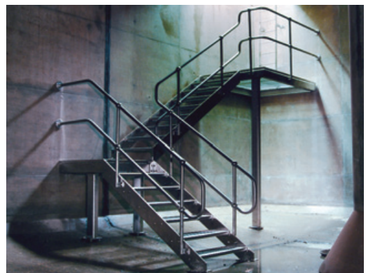
Passerelles d'accès et échelles
