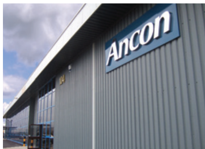
Usine de fabrication de Deeside, Pays de Galles Nord, Royaume-Uni
